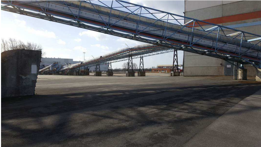
Figure 33 : Photo 5 : Vue depuis le site vers le sud-ouest (source : Goodman, 2017)
